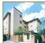
グループホームみなせⅡ号館
